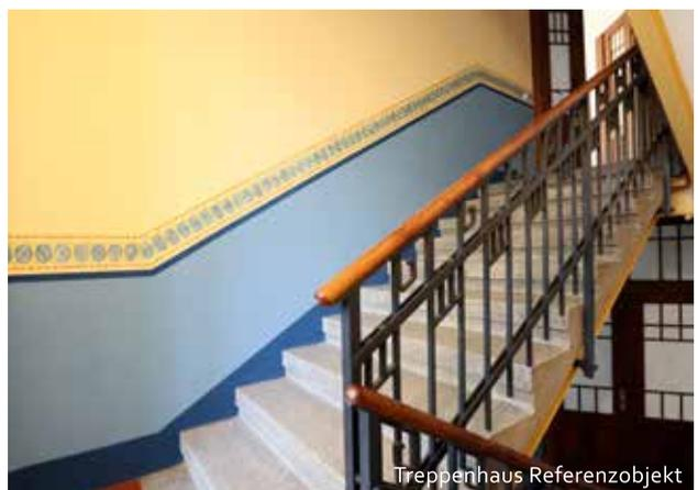
Die geputzten Wände des Treppenhauses werden instandgesetzt und mit passender Farbgebung nach Vorgabe des Denkmalschutzes künstlerisch neugestaltet. Die Beleuchtung wird erneuert und dem wertigen Gesamteindruck angepasst. Die Podeste und Treppenstufen werden aufbereitet und bei Bedarf saniert.
