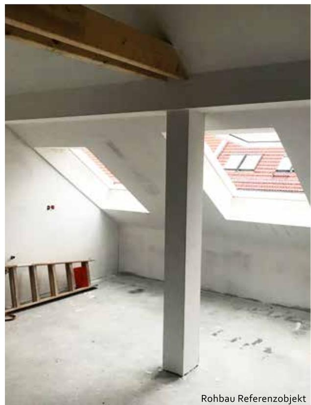
Die geforderten brand- und schallschutztechnischen Maßnahmen werden ebenfalls in Trockenbauweise ausgeführt, diese können durch den Altbestand aber nicht überall auf den heutigen Stand der Technik gebracht werden.
